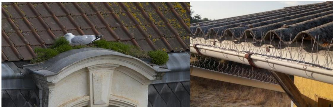
Photo 7 : L'installation de pics sur la corniche et les gouttières peut empêcher la construction d'un nid (© A. Ward).
