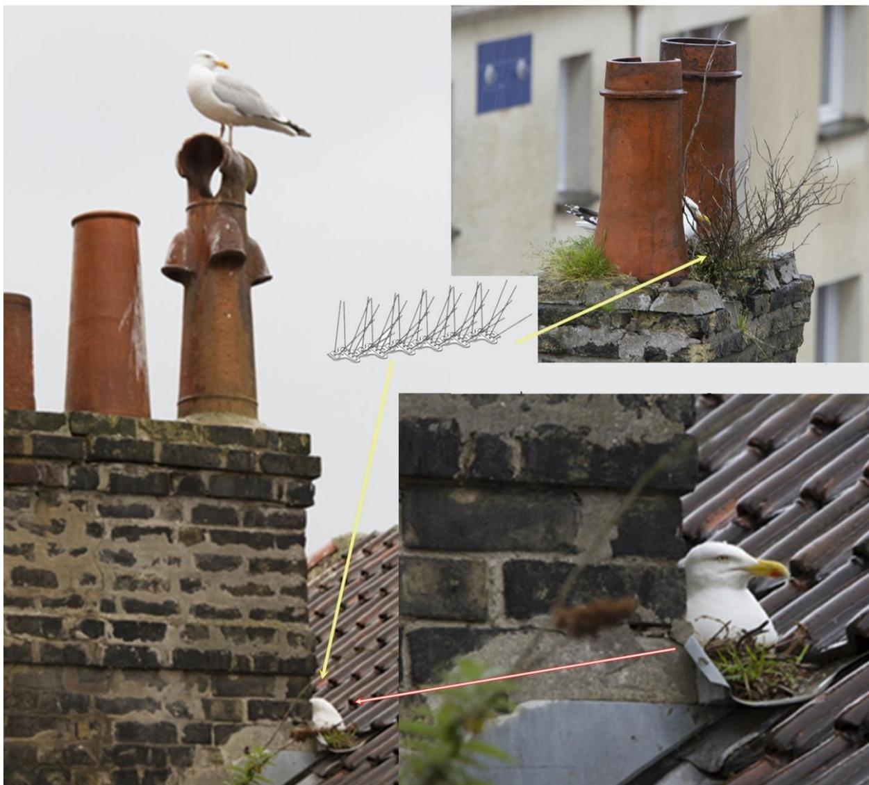
Photo 6 : Installation typique de nids sur les cheminées et toit en pente. La pose de pic est efficace. Remarque : le mâle surveille sur un point haut pendant que la femelle couve (© A. Ward).
