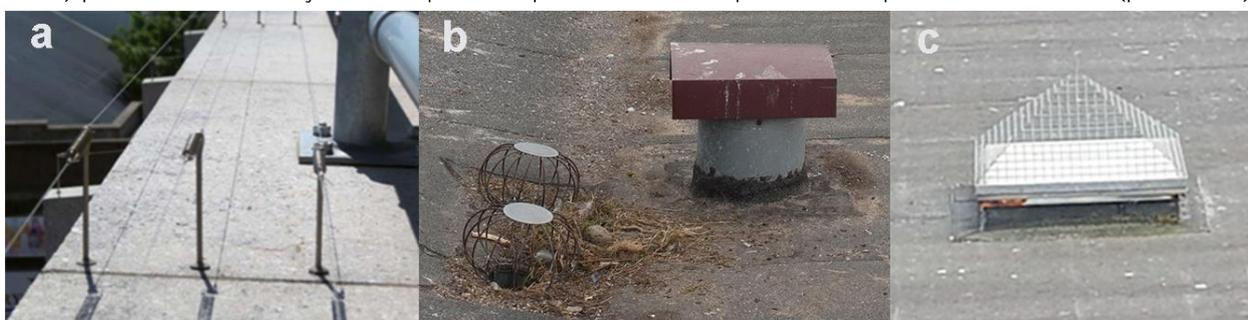
Photo 10 : (a) L'installation de câbles gêne la pose des goélands sur des espaces de sécurité ; (b) les évacuations d'eau doivent être protégées par des dispositifs bien adaptés ; (c) le dessus des fenêtres de toits peut être recouvert de dômes pour empêcher la construction de nid (© A. Ward).
